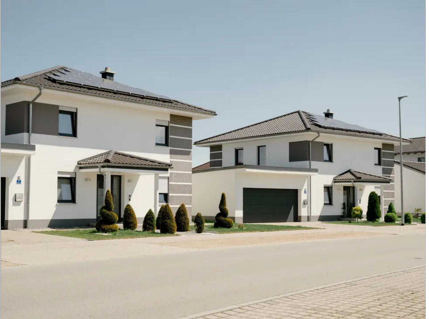
Blick auf das Dingolfinger Wohngebiet Höll Ost 3.
